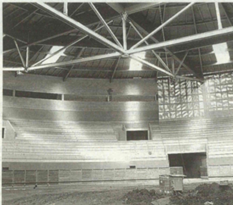
Vista de las últimas obras en el interior del 'Arnedo Arena'. :: E. P.
